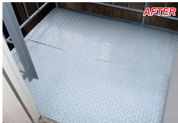
※パワー防錆 EP039 塗布後、パワー防錆 AP089 で塗装したものです
