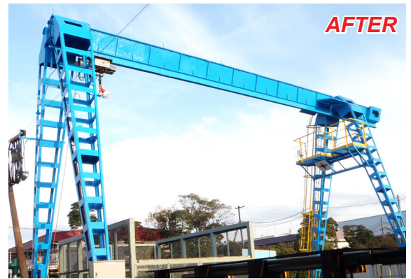
※パワー防錆 EP039塗布後、パワー防錆 AP089で塗装
