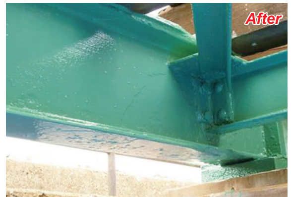
※パワー防錆 SP041塗布後、パワー防錆 AP089で塗装
