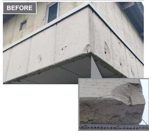
躯体内部の鉄筋が露出
