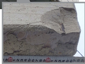
躯体内部の鉄筋が露出
