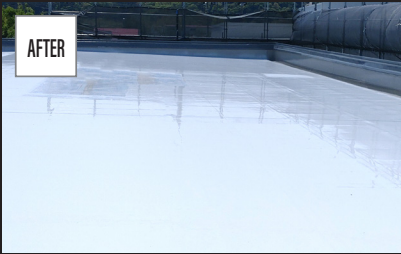
劣化したコンクリートを補修・補強し防水
