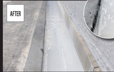
劣化した排水溝の鉄板を補修・補強し防水
