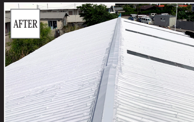
沿岸部ですぐにサビてしまう屋根を防錆補強
