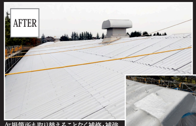
欠損箇所も取り替えることなく補修・補強
