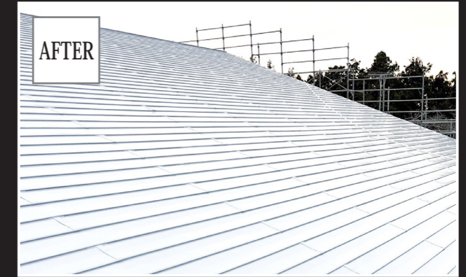
サビで劣化した鋼板屋根を防錆・補強
