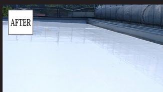
劣化した屋上のコンクリートを補強し防水
