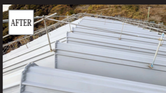
サビで劣化した銅板屋根を補修し防水
