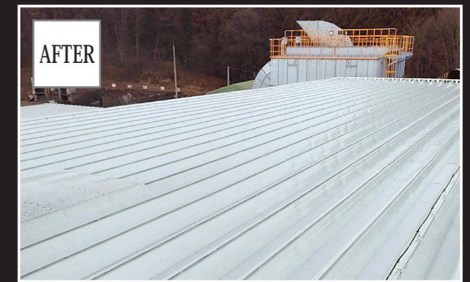
サビや紫外線で劣化し変色した折板屋根を補修・補強
