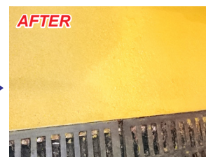
■グリ石がむき出しになった床でも、塗装だけで平坦に
