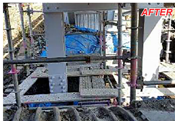
※パワー防錆 SP041 塗布後、パワー防錆 AP089 で塗装
